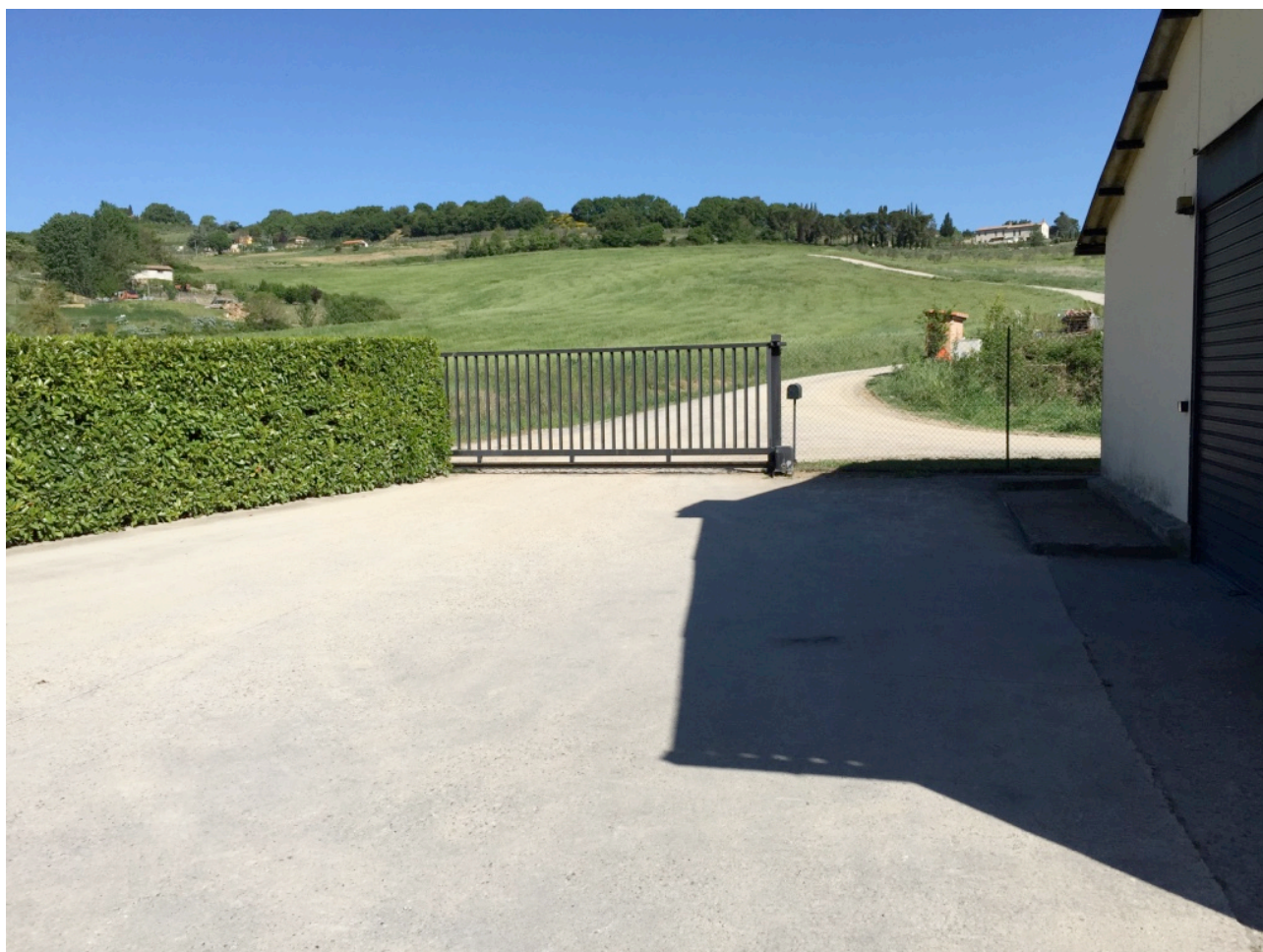
Foto n.3 ingresso principale capannone
