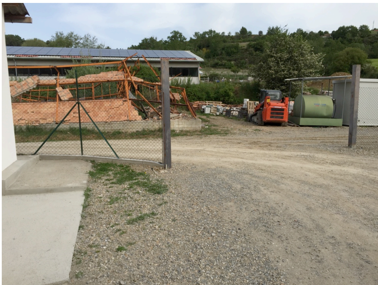
Foto n.4 ingresso secondario capannone
