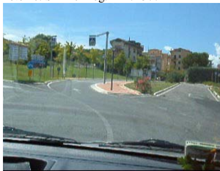
Foto 18: SP 146 Prog. km 0+500
