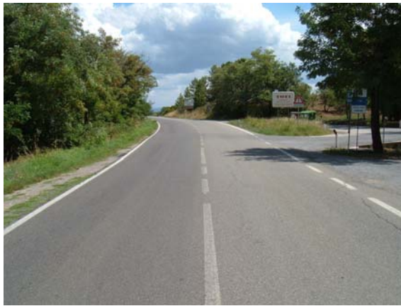
Foto 5: SP 40 Ubicazione punto di misura della sezione trasversale
