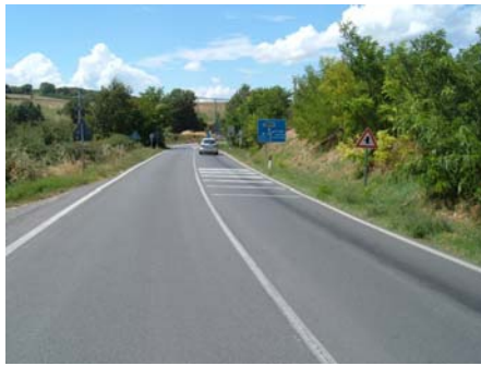
Foto 11: SP 146 Ubicazione punto di misura della sezione trasversale
