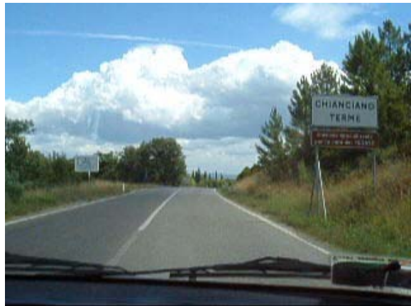
Foto 6: SP 40 Prog. km 0+000
