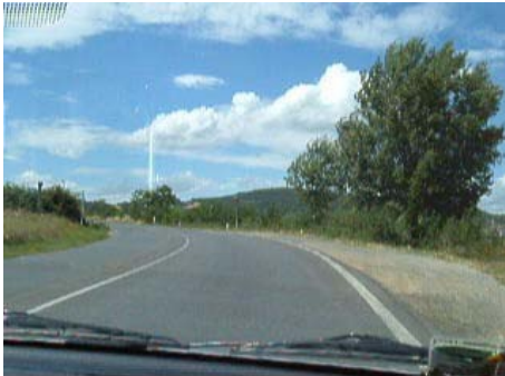
Foto 13: SP 146 Prog. km 0+000
