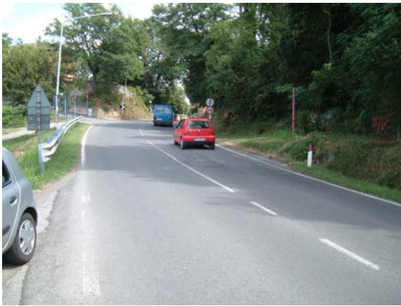
Foto 20: SP 146 Ubicazione punto di misura della sezione trasversale
