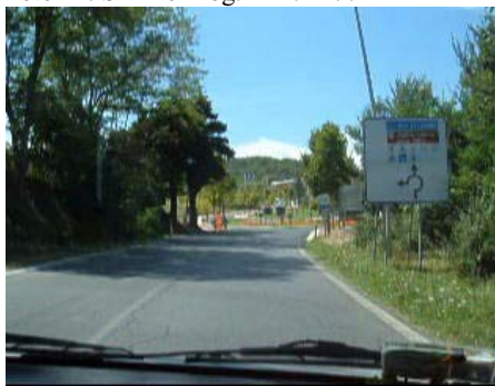
Foto 16: SP 146 Prog. km 0+300
