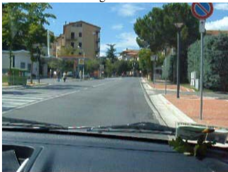
Foto 19: SP 146 Prog. km 0+600
