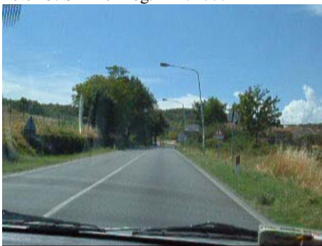
Foto 15: SP 146 Prog. km 0+200
