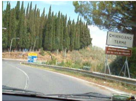
Foto 21: SP 146 Prog. km 0+000
