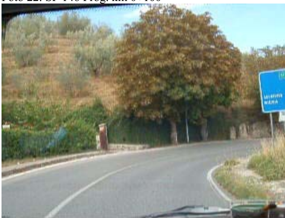
Foto 24: SP 146 Prog. km 0+300
