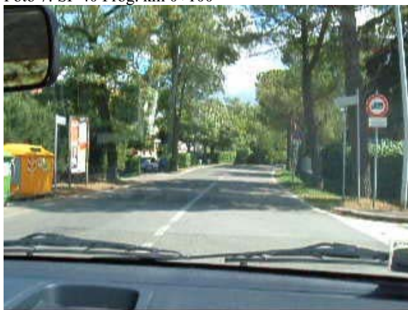
Foto 9: SP 40 Prog. km 0+300
