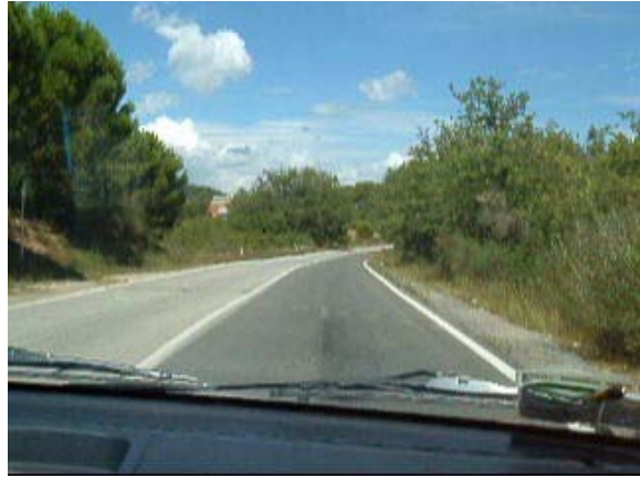
Foto 2: SP 19 Prog. km 0+000
