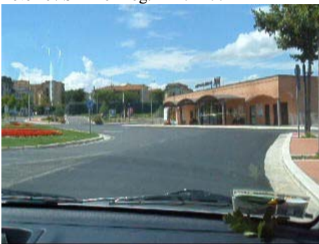
Foto 17: SP 146 Prog. km 0+400
