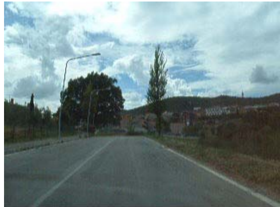
Foto 37: VIA DELLA VALLE Prog. km 0+100
