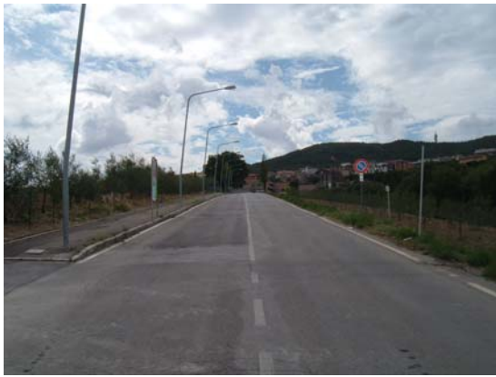
Foto 34: VIA DELLA VALLE Ubicazione punto di misura della sezione trasversale
