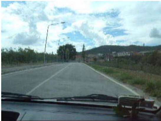
Foto 36: VIA DELLA VALLE Prog. km 0+000
