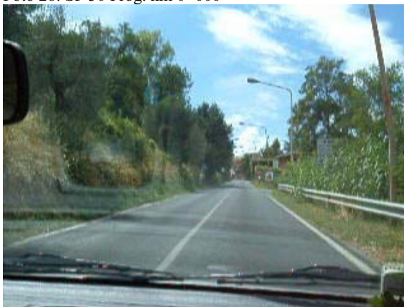
Foto 30: SP 30 Prog. km 0+200
