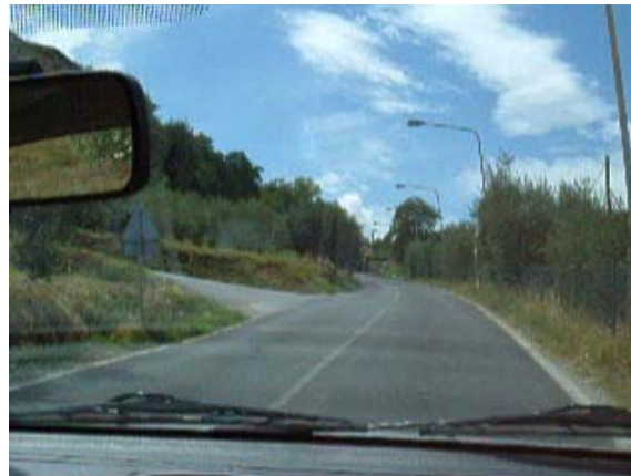
Foto 29: SP 30 Prog. km 0+100
